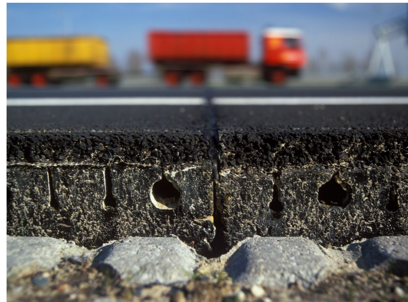
Aanleg van duurzaam asfalt vermindert CO 2 -uitstoot
